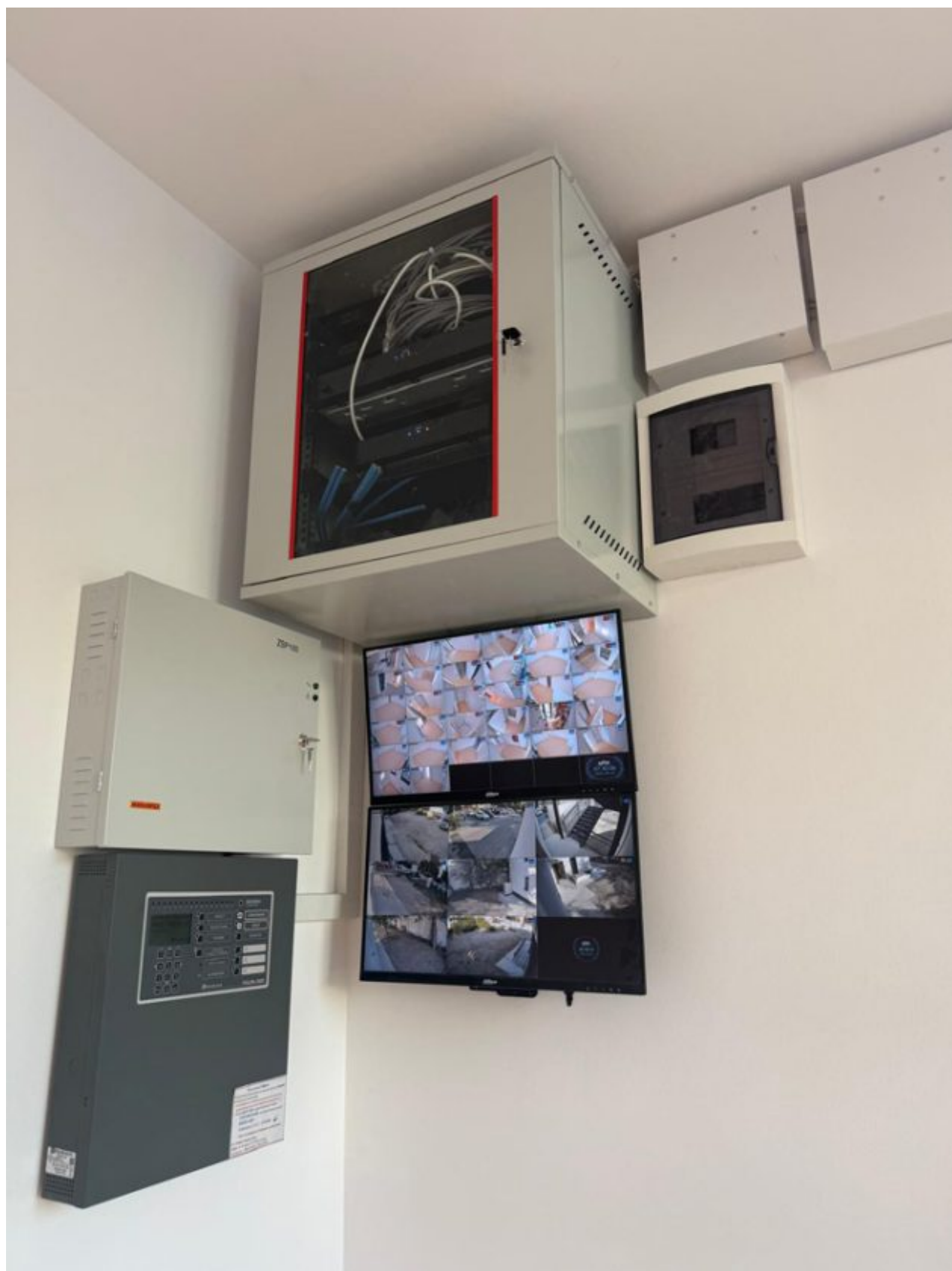
Renovare energetică la Creșa nr. 8 - Smeurei din
